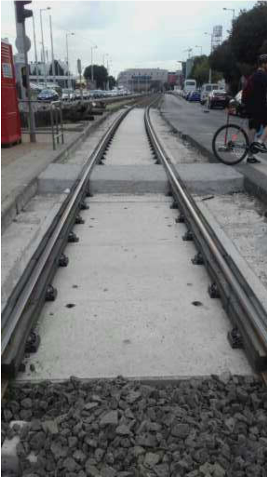
1-es villamos, Ferencváros megálló útátjárója később aszfalt burkolattal ellátva (2018, zzk, R=600m)
